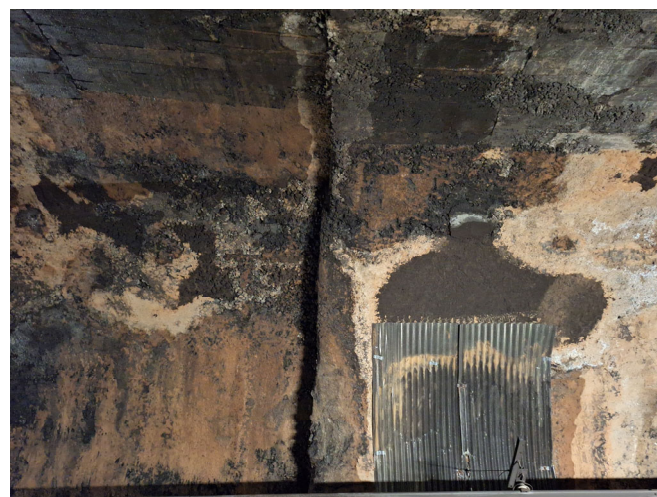
Foto 4: Detall de superfícies de formigó escrostonades
